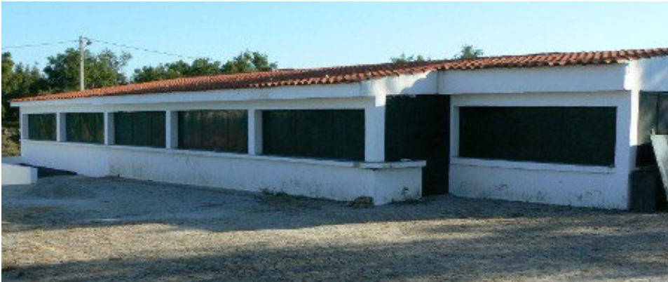
O novo edifício de apoio ao Restaurante e Bar
